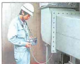
▲ダクト内の風速・静圧測定に
