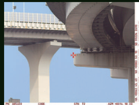
構造物計測 * 実写例
