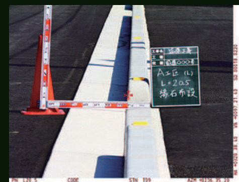
施工管理測量 * 実写例
