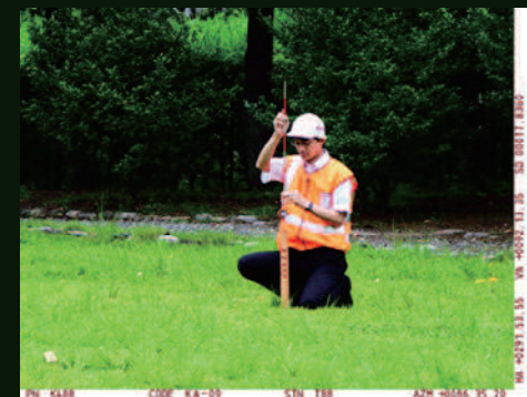
測設後の検測 * 実写例
